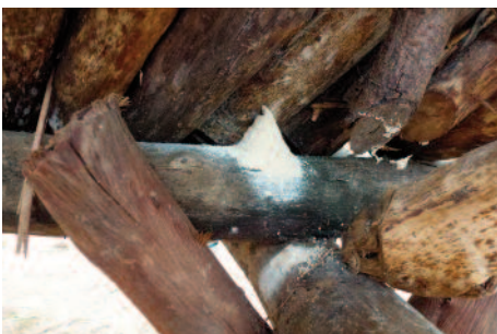
Figure 4 : Vérifier tous les bois de la structure
