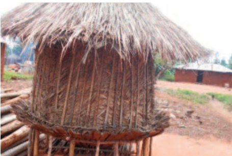
Figure 3 : Grenier en nervures de palmier
